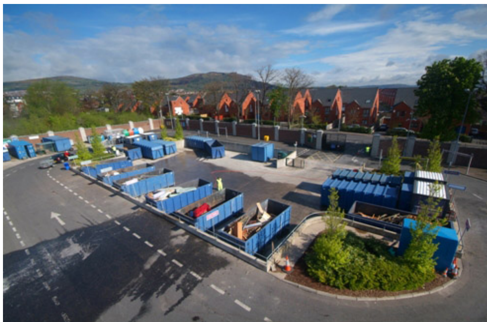
Слика 6.12. Изглед једног рециклажног дворишта
